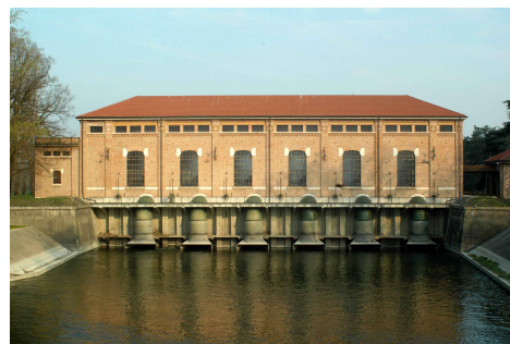
Fig.9. Museo della Bonifica –Impianto Idrovoro di Saiarino(foto C. Occhi).
